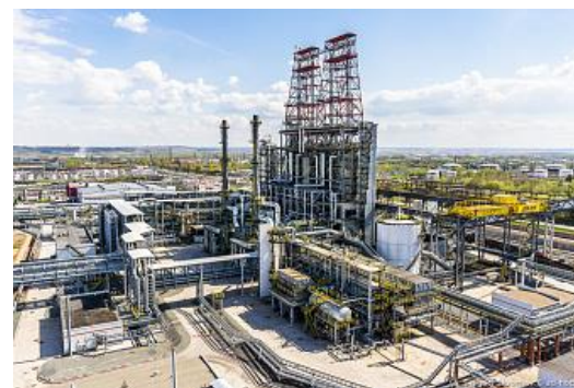
в нефтегазовой, горнодобывающей, теплоэнергетической отрасли
